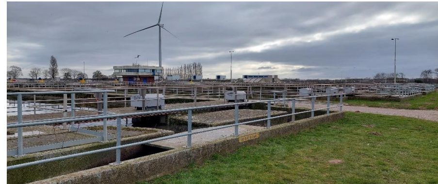
Rioolzuivering Nieuwveer Breda
