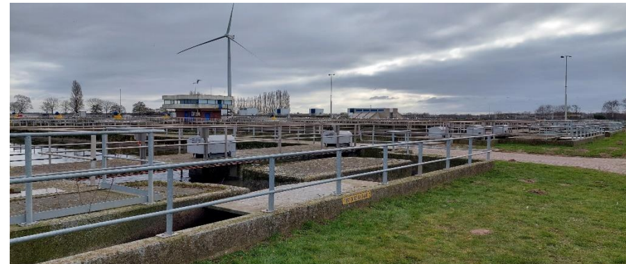
Rioolzuivering Nieuwveer Breda
